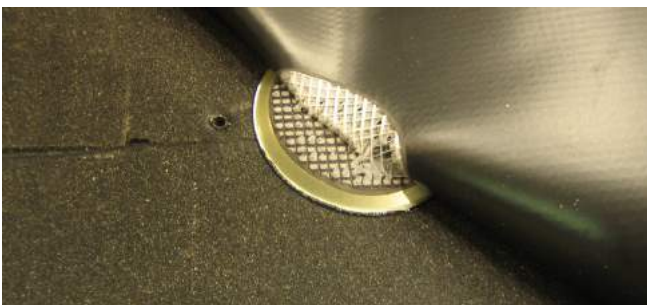
Prova di tenuta della piastra che normalmente si esegue in cantiere: il lato inferiore della membrana deve rimanere bene aderente alla parte superiore della piastra.
